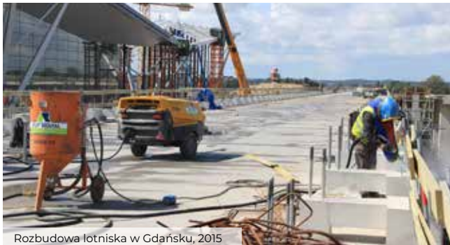
Rozbudowa lotniska w Gdańsku, 2015
