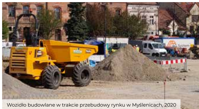
Wozidło budowlane w trakcie przebudowy rynku w Myślenicach, 2020
