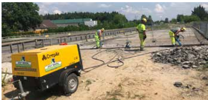
Sprężarka zasilająca narzędzia pneumatyczne podczas modernizacji jezdni, 2020
